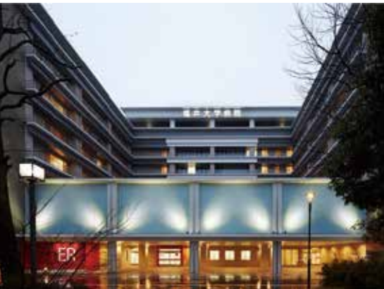
写真4 新病棟の外観。
